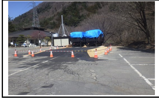
現地写真2-1 竜島温泉せせらぎの湯 ウッドチップボイラー 燃料コンテ
