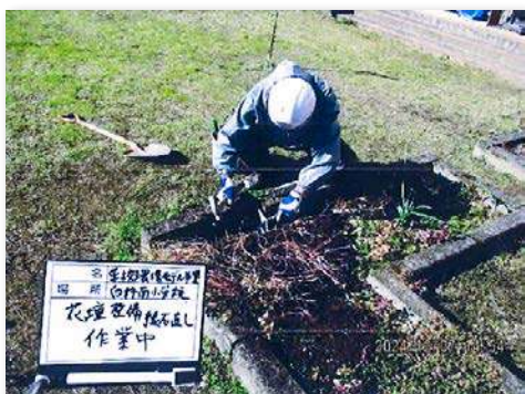
花壇整備(作業中)
