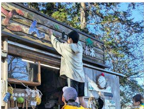
小屋の看板を修繕
