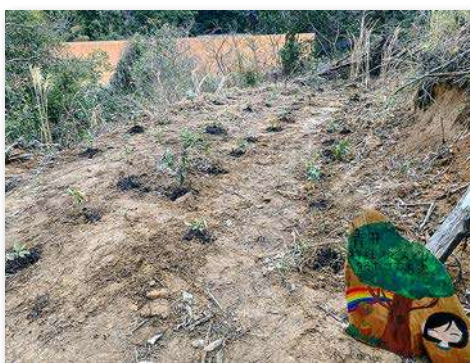
植樹箇所に看板を設置
