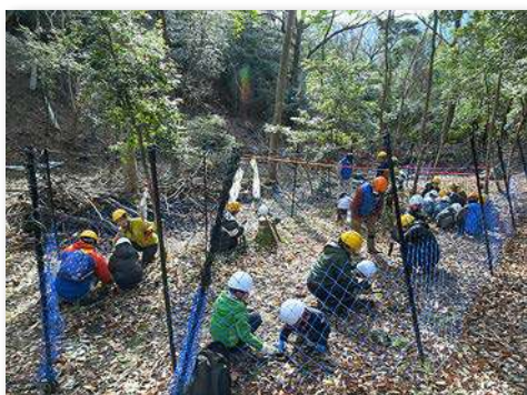
防護柵を設置
