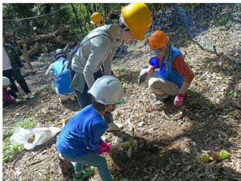
ツルハシで植樹のための穴掘り
