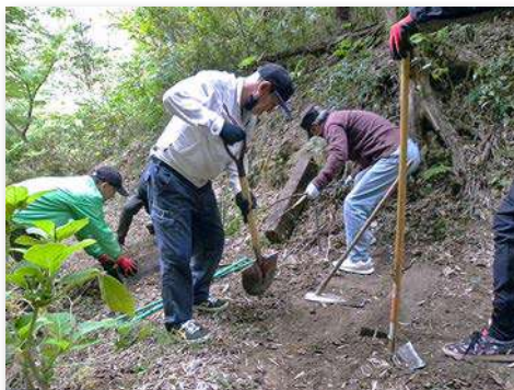
階段の枕木を交換
