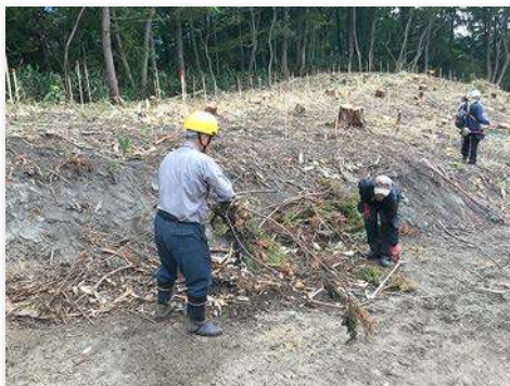
植樹対象エリアの草刈・片付け作業
