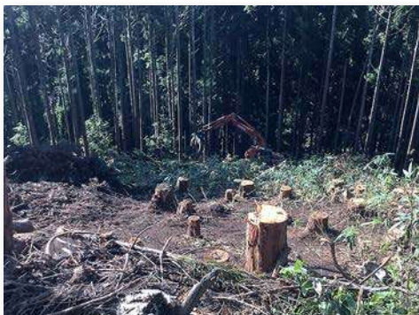
重機での地拵え作業
