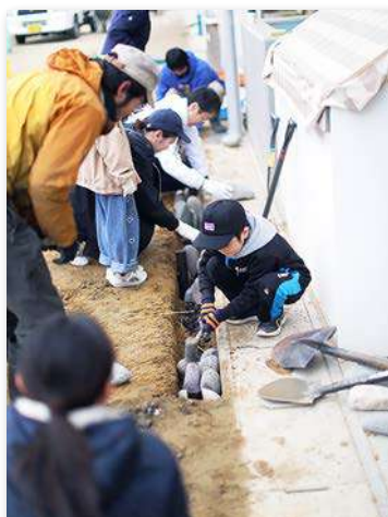
排水溝を掘って石を敷く作業(親子メンテナンスDAY)
