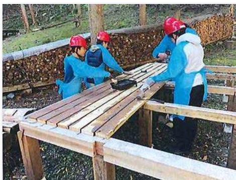
ツリーハウスの土台等の防腐剤の塗装
