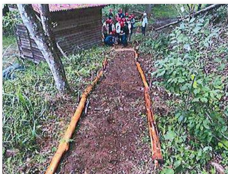
作業道の整備
