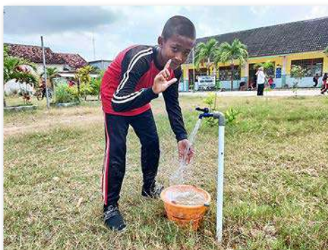
小学校に設置した雨水貯蔵設備から引いたパイプから、散水用の水を汲む子ども
