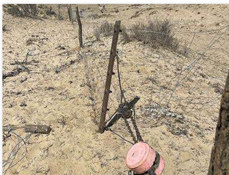
事業地外周に金網防護柵を設置
