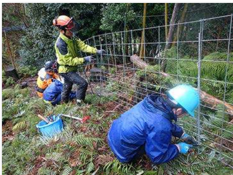
防護柵設置作業
