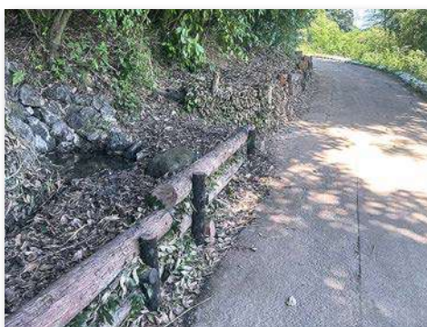
寺参道 (完成した土留めと湧水石積)
