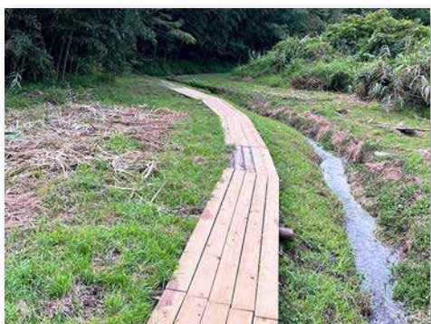
修繕した木道
