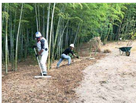
散策路へ木チップを敷均し
