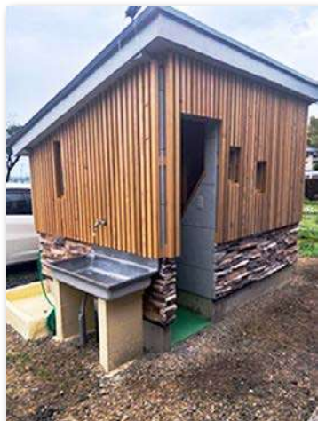
活動拠点のトイレ完成
