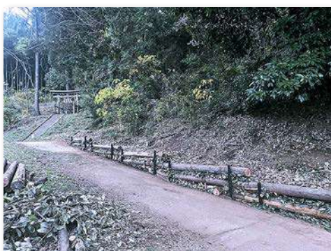
神社参道土留め完成写真
