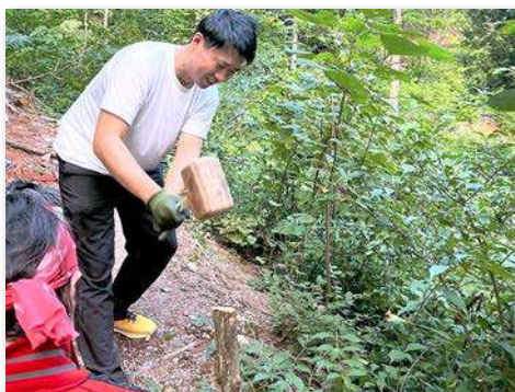
崖崩れ復旧における杭打ち作業
