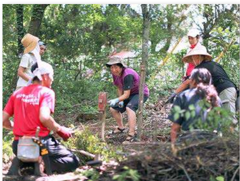
土留の杭打ち
