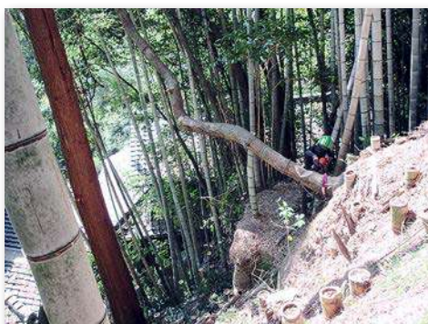
支障木の伐採
