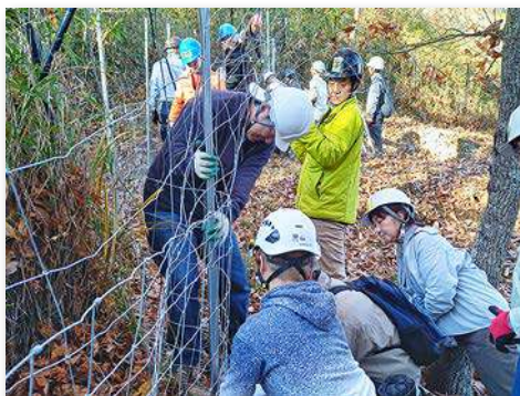
防鹿柵設置作業
