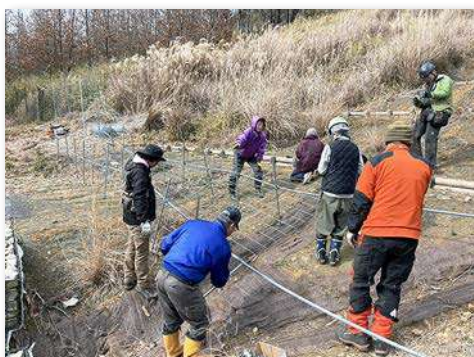
山腹崩壊地への防鹿柵設置
