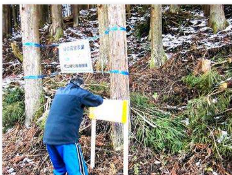
事業看板を設置
