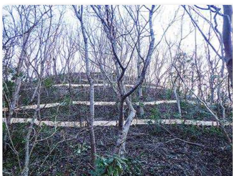
土を掘り後に板を設置(植樹地整備)
