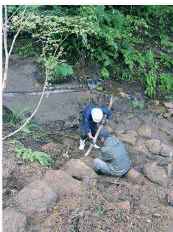
手作業で石組み
