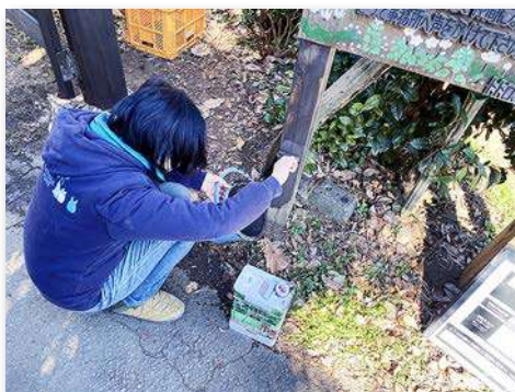
看板の修繕(クロスケの家)
