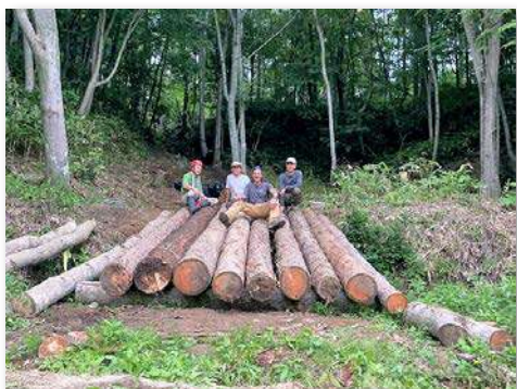
作業道橋修繕
