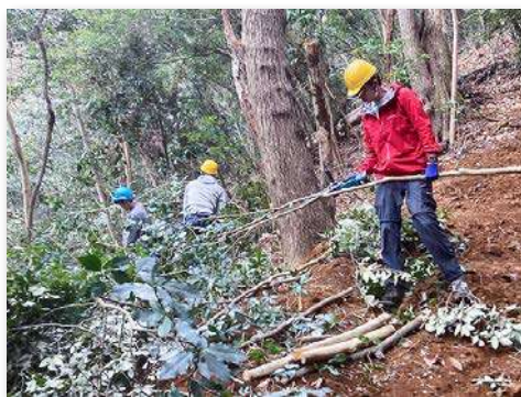
灌木選定と土留め造作作業
