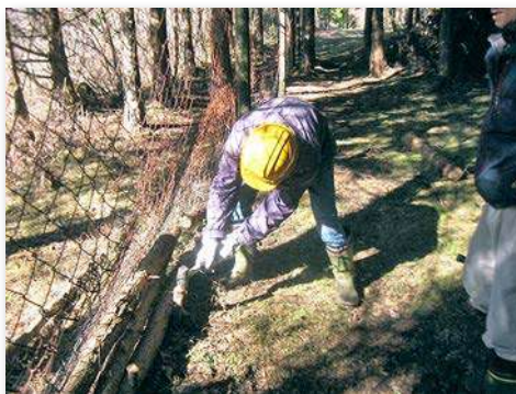
網下の隙間の補修作業
