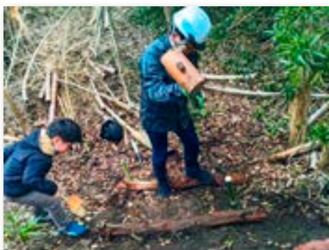
現地の枯れ木、タケを使用して階段整備
