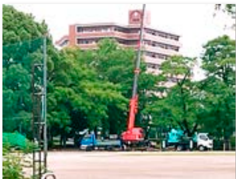
大木の伐採作業
