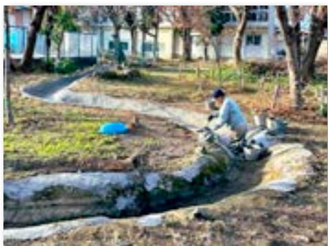
校内ビオトープ「生き物の森内さくらぎ川・さくらぎ池」の護岸改修
