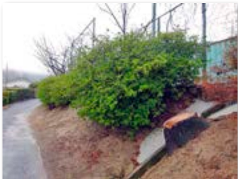
樹木伐採後の様子
