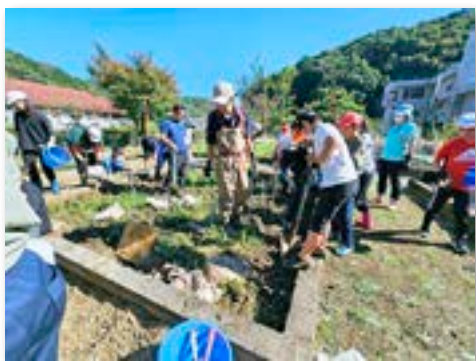
ビオトープになる予定の池に石と休耕田の土入れ
