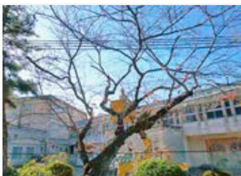
高所作業車で剪定・枝払作業
