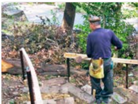
階段には手すりを設置
