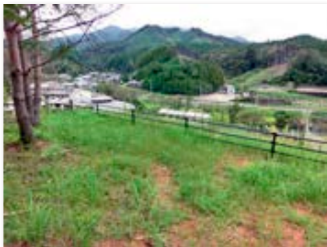
安全柵の設置
