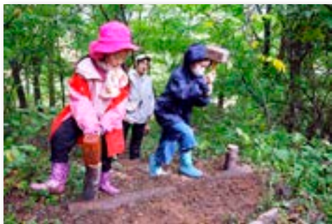
階段増設作業
