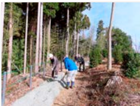
遊歩道の整備（碎石敷均）
