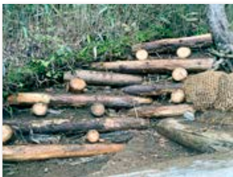
法面に井桁の木組みで土壌の安定を図る
