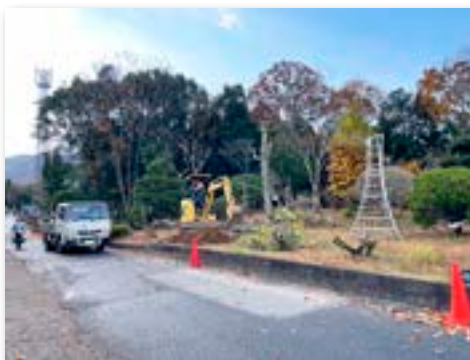
重機による土留め補修及び植樹準備
