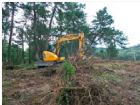
重機による抜根及び整地作業
