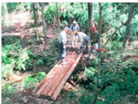
林道の丸太橋の架け替え作業
