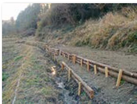
横井戸へのルートを整備
