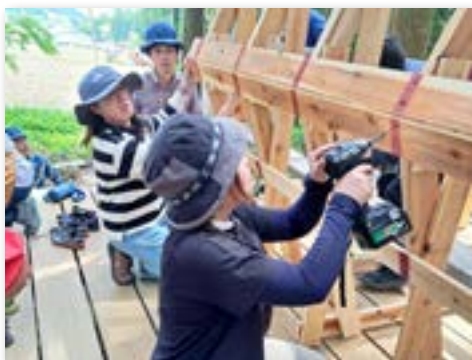
トラスの組み立て
