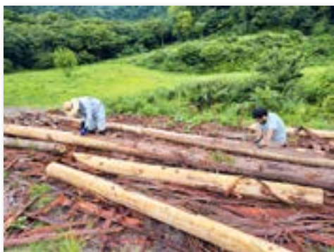
ツリーハウス用に木を伐倒後、皮むきを実施
