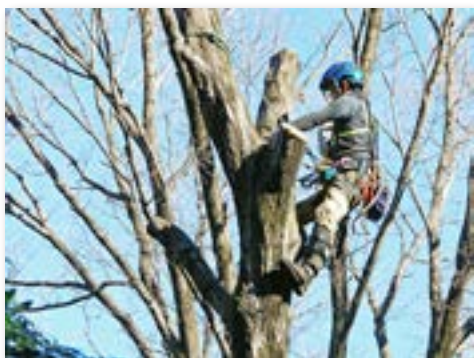
高所での作業
