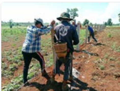
獣害防止柵の設置
