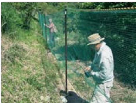
防獣ネット補修
