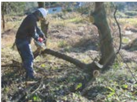
支障木の伐採
