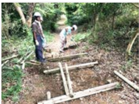
間伐材を使ってハイキングコースの階段設置
