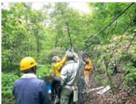
シカ防護柵の設置
