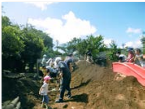
園庭緑化に向けた植栽基盤の造成工事
