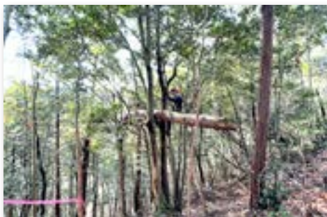
支障木を除去
