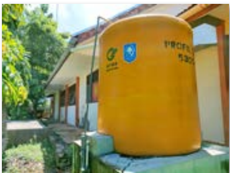
設置した雨水貯水設備
