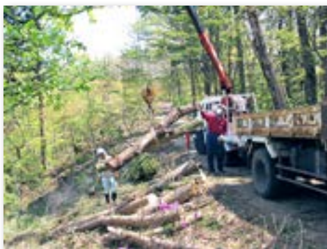
支障木の伐採
