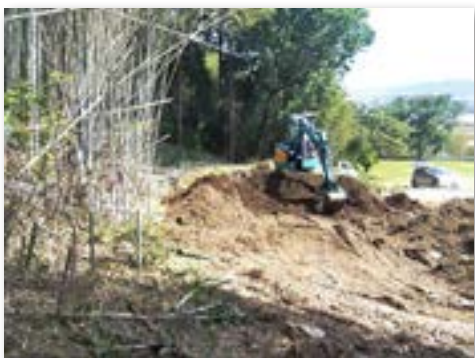
拠点活動エリア整備
