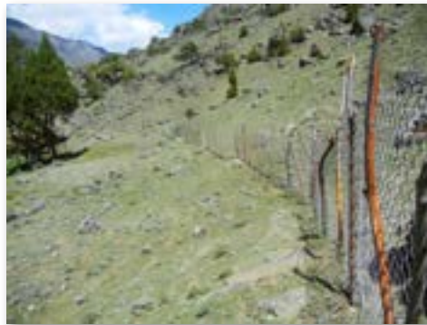
防護柵を設置
