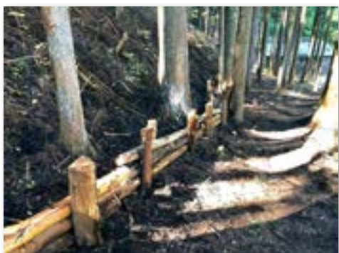
作業道整備後
