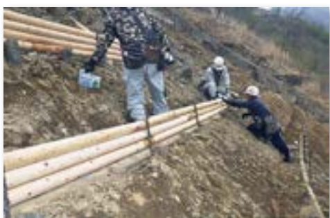
丸太で木柵をつくり土の流出を防ぎ苗木の活着率を高める
