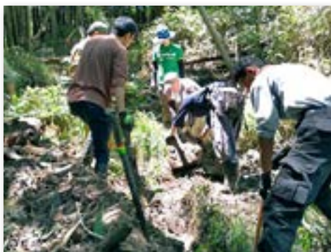
水脈整備（詰まった泥や石を除去）
