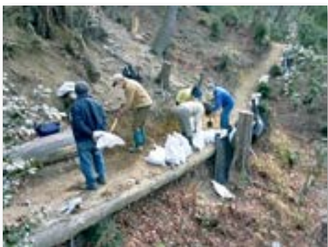
豪雨で崩壊した散策道の補修
