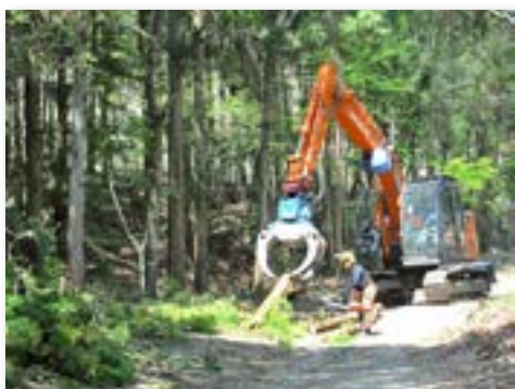
支障木などの伐採
