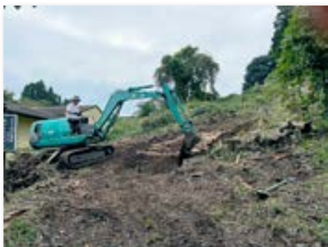
散策道を整備
