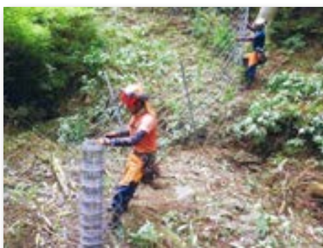
獣害防止柵の設置
