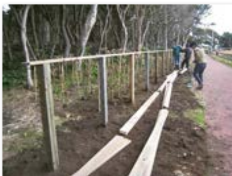
防風垣の設置
