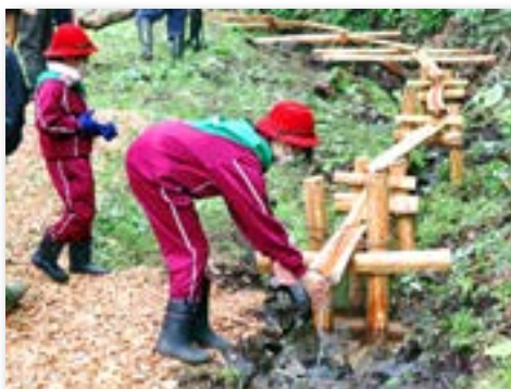
手洗い場整備
