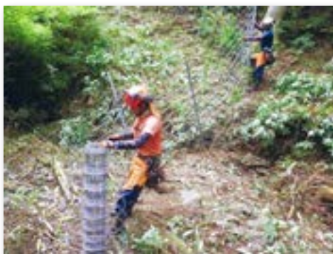
獣害防止柵の設置
