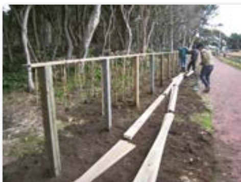
防風垣の設置
