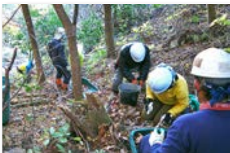
災害対策研修での作業道補修
