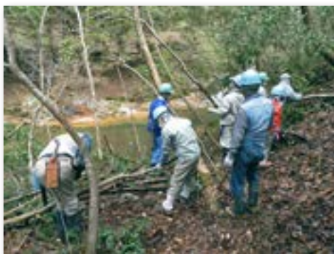
遊歩道の倒木処理
