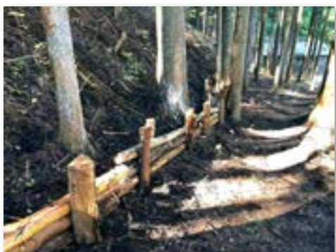
作業道整備後
