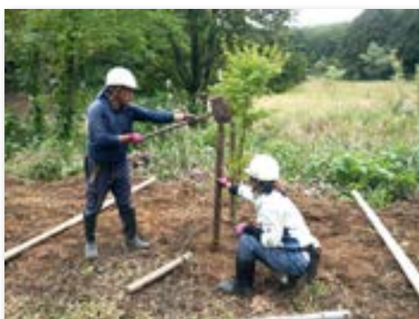
支柱を立てる
