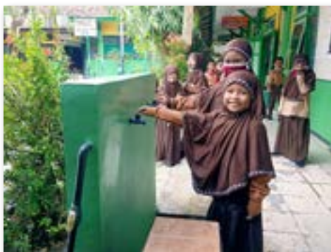
雨水貯蔵設備とあわせて設置した手洗い場(小学校)
