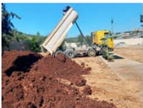
植樹地に土を入れる
