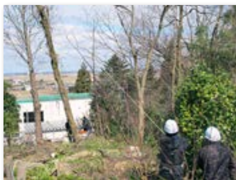
支障木の伐採
