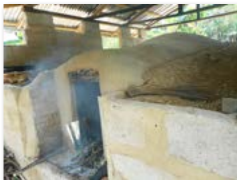
修繕した炭窯での炭焼き
