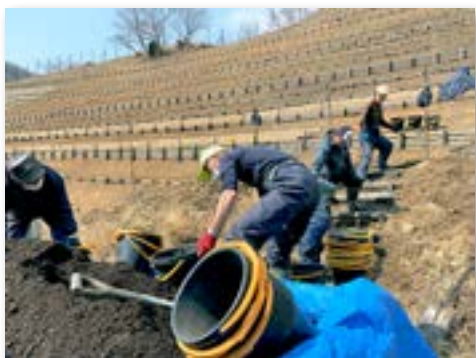
土が流失しているところに黒土を入れる
