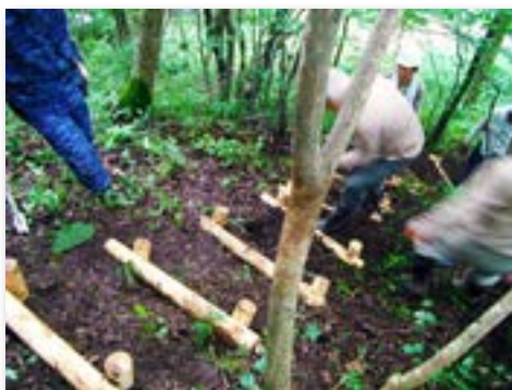
歩道整備(金蔵地区)
