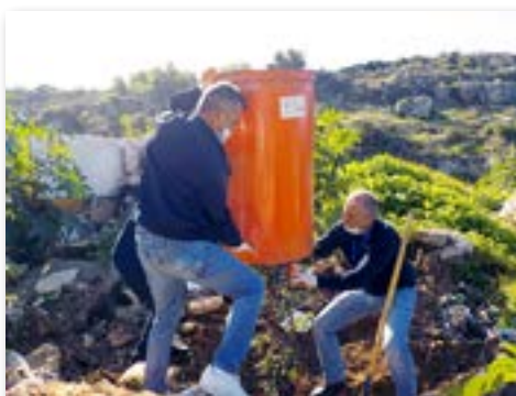
苗木の囲いを設置
