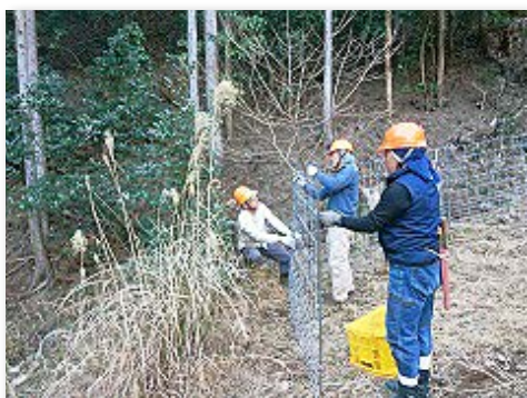
シカ除け柵設置中
