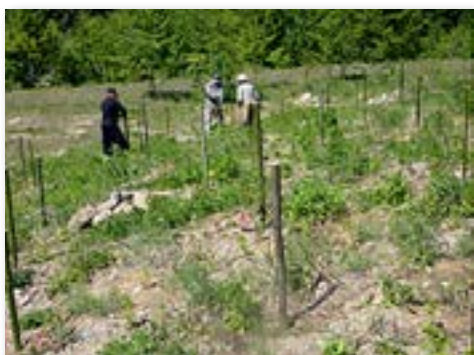
支柱を立てる
