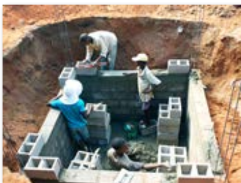
貯水タンク建設
