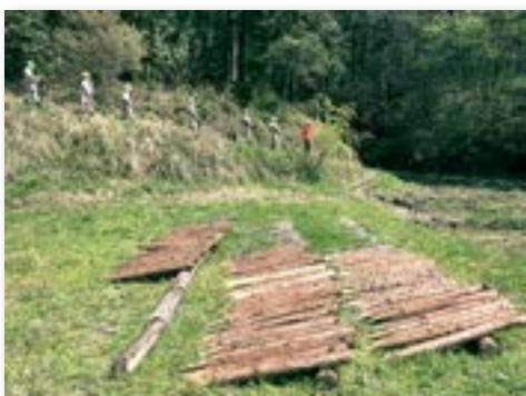
伐り出した間伐材を杭に加工 (八王子)
