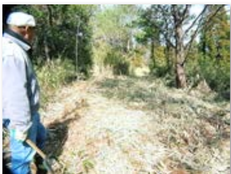
基幹通路の整備
