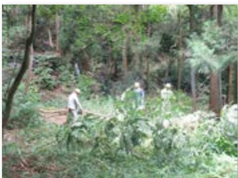
支障木などを伐採
