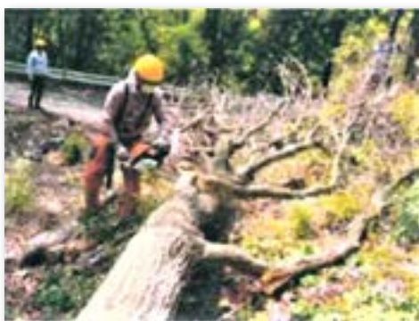
危険木の処理
