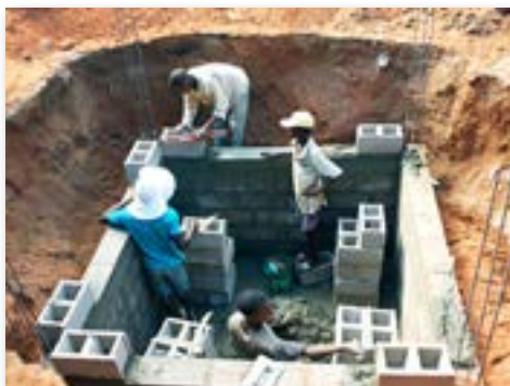
貯水タンク建設
