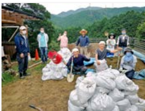
斜面修復用の土のうづくり
