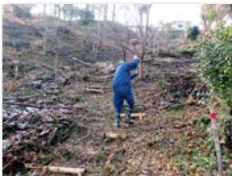
管理道の補修
