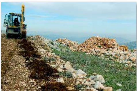
植樹用の穴の掘削
