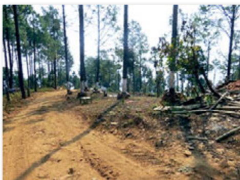
植林地の歩道、作業道づくり
