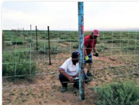
フェンス設置
