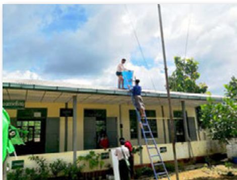
給水用資材設置
