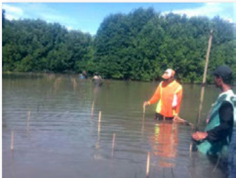
植樹のためタケの支柱設置
