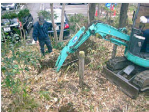
植樹穴の掘削
