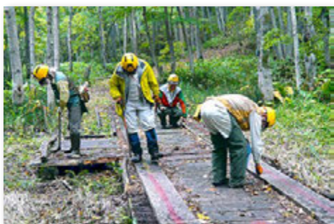
木道補修箇所の点検
