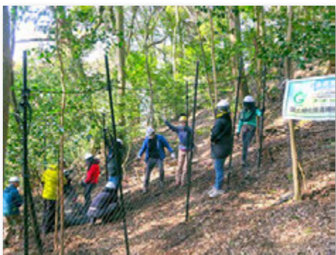
防鹿柵の設置
