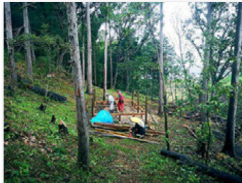
ウッドデッキ設置
