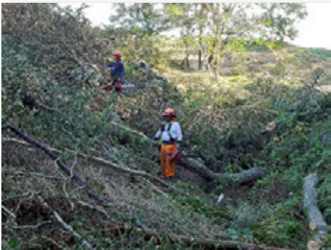
支障木の伐倒
