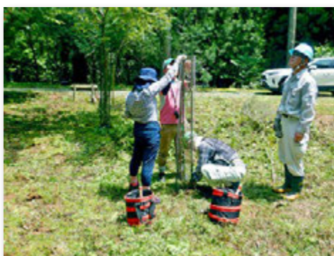
食害対策防護ネットの補修
