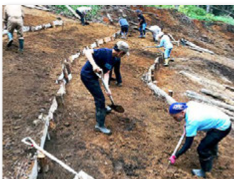
地滑り斜面の崩壊を防ぐため、利用者や来訪者といっしょに進める土留作業
