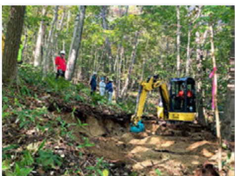
作業道敷設研修
