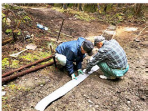
丸太横断溝の敷設
