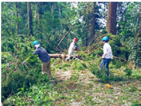
台風被害復旧作業
