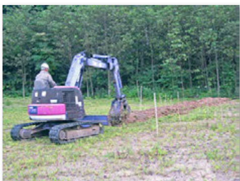
排水路づくり
