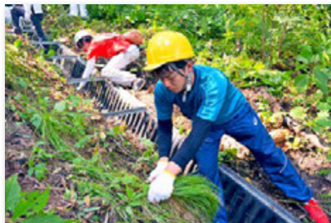
水路周辺の整備
