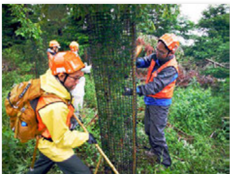
獣害対策ネット補修
