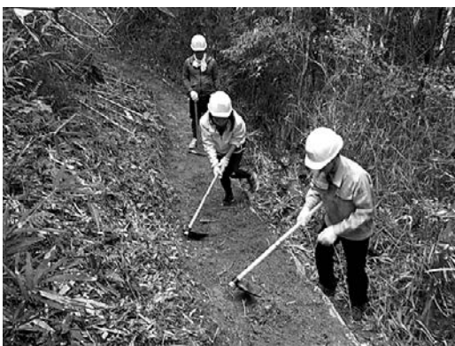
作業道の補修
