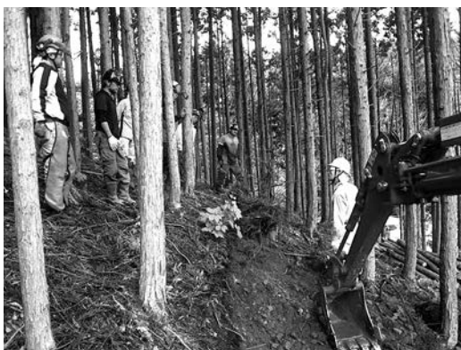
作業道敷設研修
