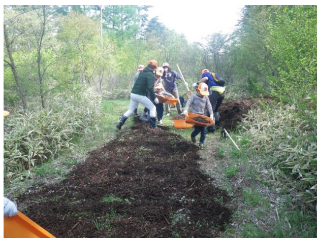
画像名：〇〇地区、作業道の修理_2019.2.15
